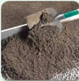
Mörtel aufbringen und über Lehren abziehen
