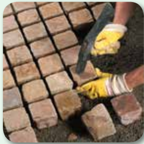
Pflaster hammerfest setzen
