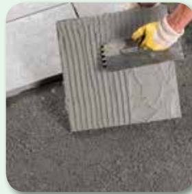
bei Platten unterseitig HaftBrücke auftragen
