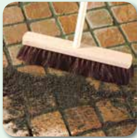
mittels feuchtem Besen abfegen
