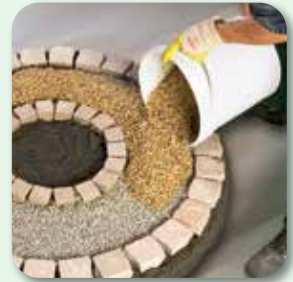
Appliquer le mortier de gravier
